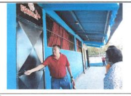
Foto 5: Puertas a remozar, lamina delgada y puerta mal colocada
